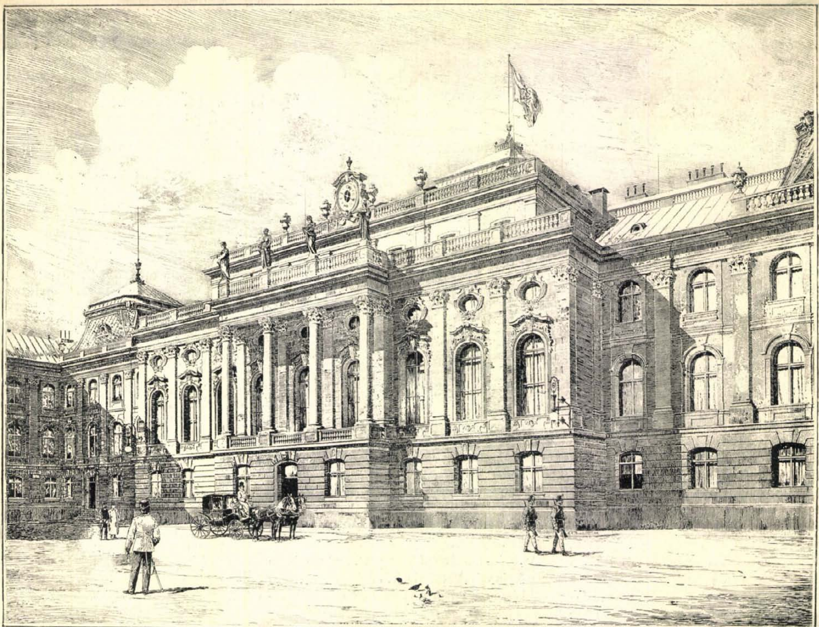
A BUDAI KIRÁLYI PALOTA ÉPÍTÉSE. — Az új udvari homlokzat, a hol a trónterem van.
